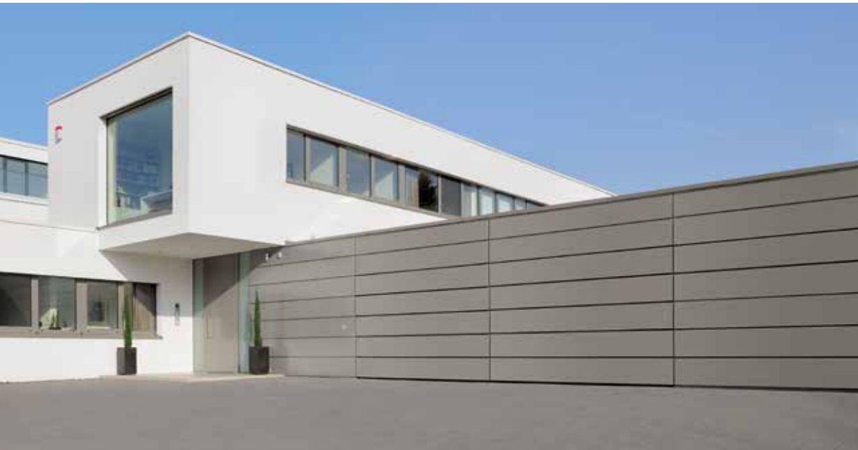
Opláštění hliníkovými sendvičovými deskami u zákazníka
